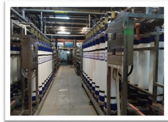
废水回用：净化后作为生产用水水源补充
